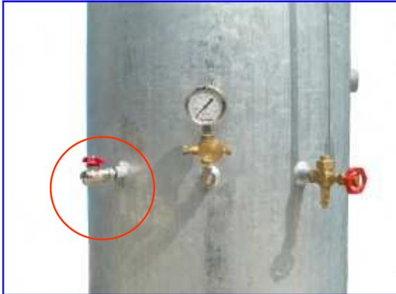
Montare la valvola a sfera  $\varnothing 1/2''$  (2) su uno dei raccordi  $\varnothing 1/2''$  solitamente utilizzati per pressostato o manometro, presente nella parte bassa dell'autoclave.
